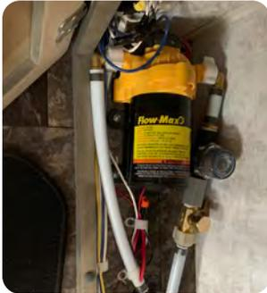
Lorsque vous n'êtes pas connecté à l'eau de la ville, vous devez vous assurer de mettre la pompe à eau en marche. Celle-ci fonctionne sur un courant de 12 volts ou sur le courant alternatif de 120 volts. Elle puise son eau dans votre réservoir d'eau potable. Elle est située généralement près du réservoir, dans un coffre ou une armoire.
