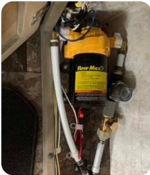
Lorsque vous n'êtes pas connecté à l'eau de la ville, vous devez vous assurer de mettre la pompe à eau en marche. Celle-ci fonctionne sur un courant de 12 volts ou sur le courant alternatif de 120 volts. Elle puise son eau dans votre réservoir d'eau potable. Elle est située généralement dans un coffre.
